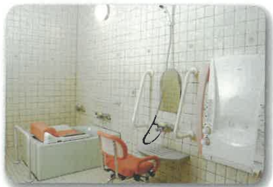
ユニット浴室
